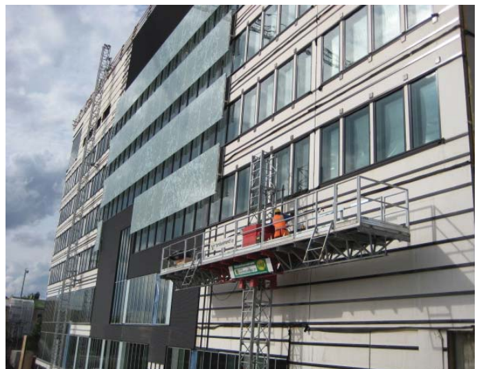
Pintaverhosten asennus Tehoranka-elementin päälle.
