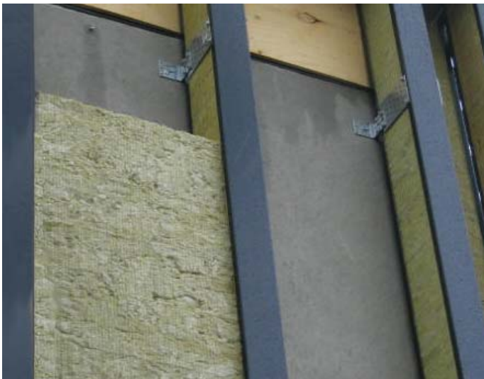
Tehoranka kiinnittyy betoniseinään.
