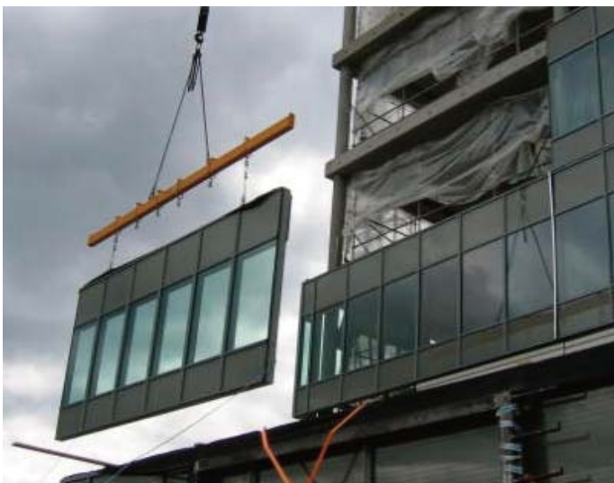
Ikkunallisen Tehoranka-elementin asennusnosto.
